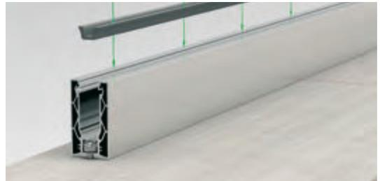
**2** Unteres Verglasungsprofil einsetzen (im Außenbereich an den Entwässerungsbohrungen aussparen)
